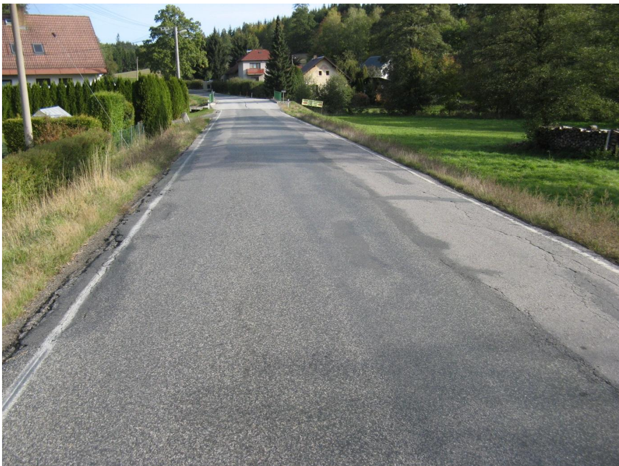
F33, km 9,010+ Síťové trhliny s deformacemi podél okrajů vozovky.
