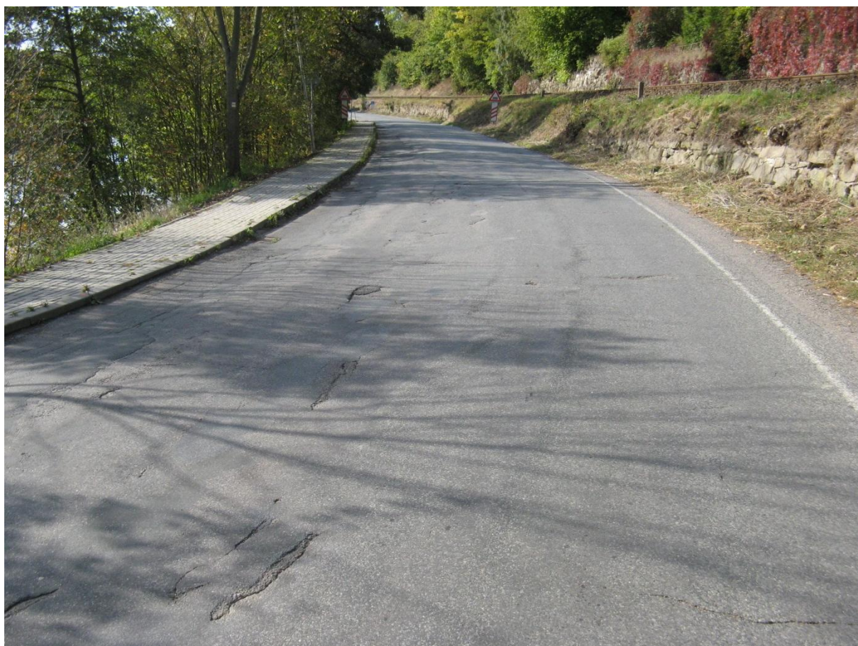
F23B, km 8,550- Trhliny, výtluky a plošné deformace nebo nepravidelné hrboly.
