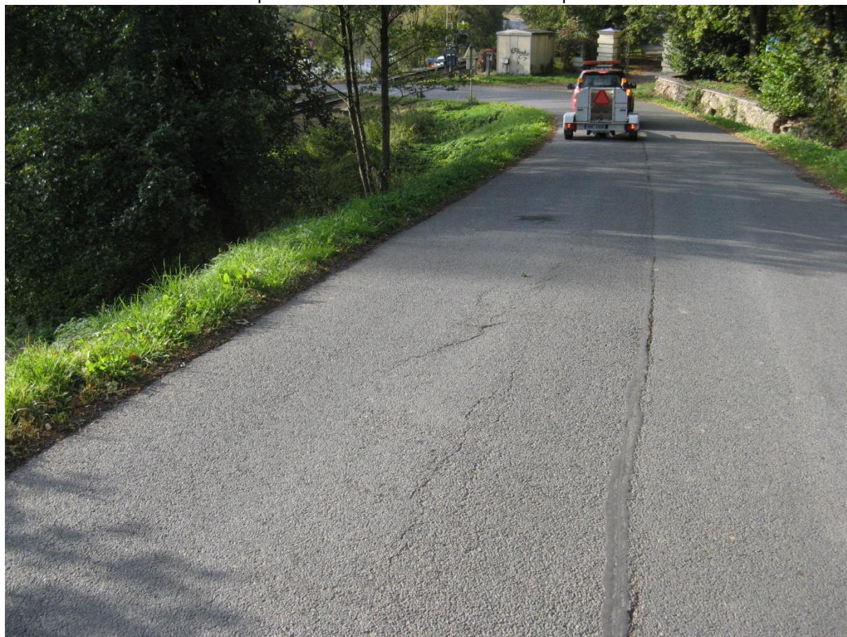
F09, km 5,030+ Podélné rozvětvené trhliny.
