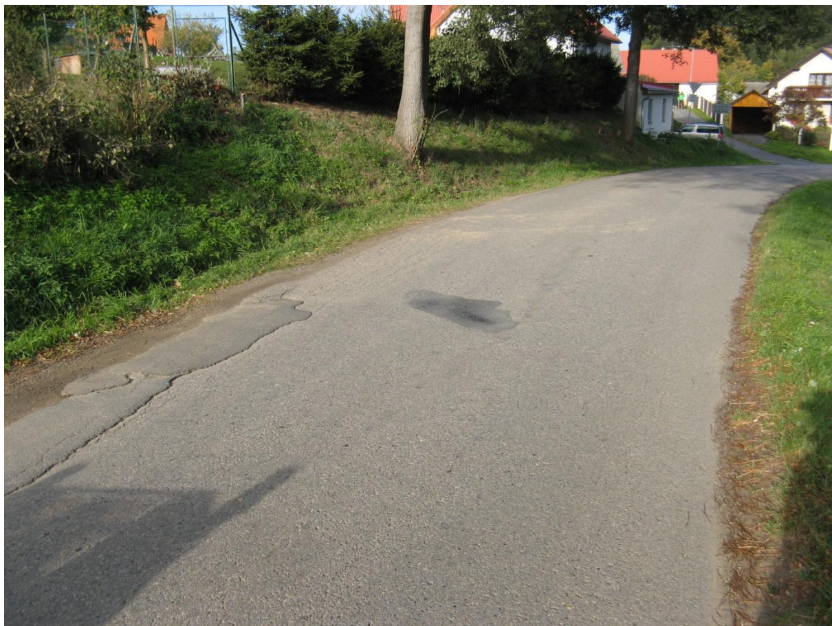
F09, km 0,400- Síťové trhliny s vysprávkami.
