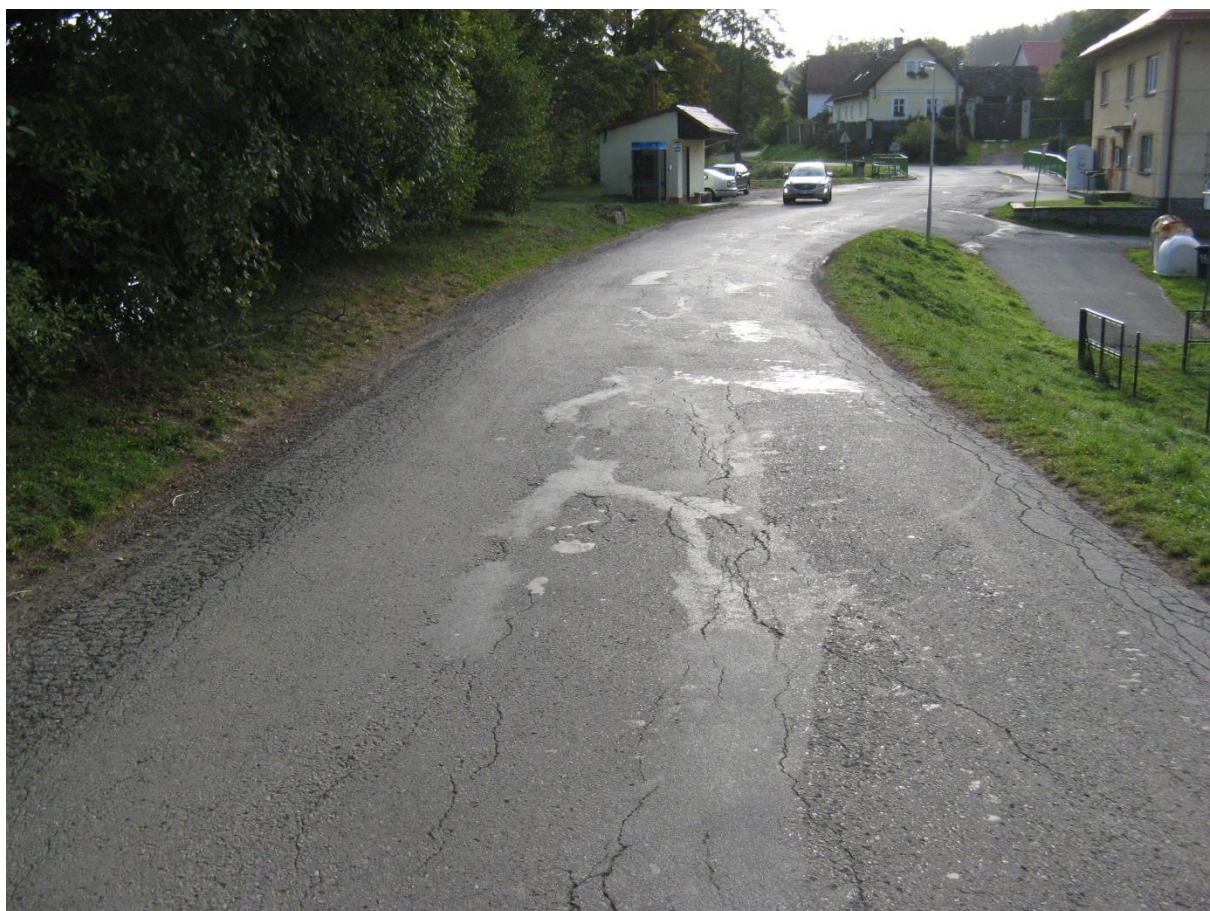
F04, km 0,110+ Síťové trhliny podél okrajů a podélné rozvětvené trhliny uprostřed.
