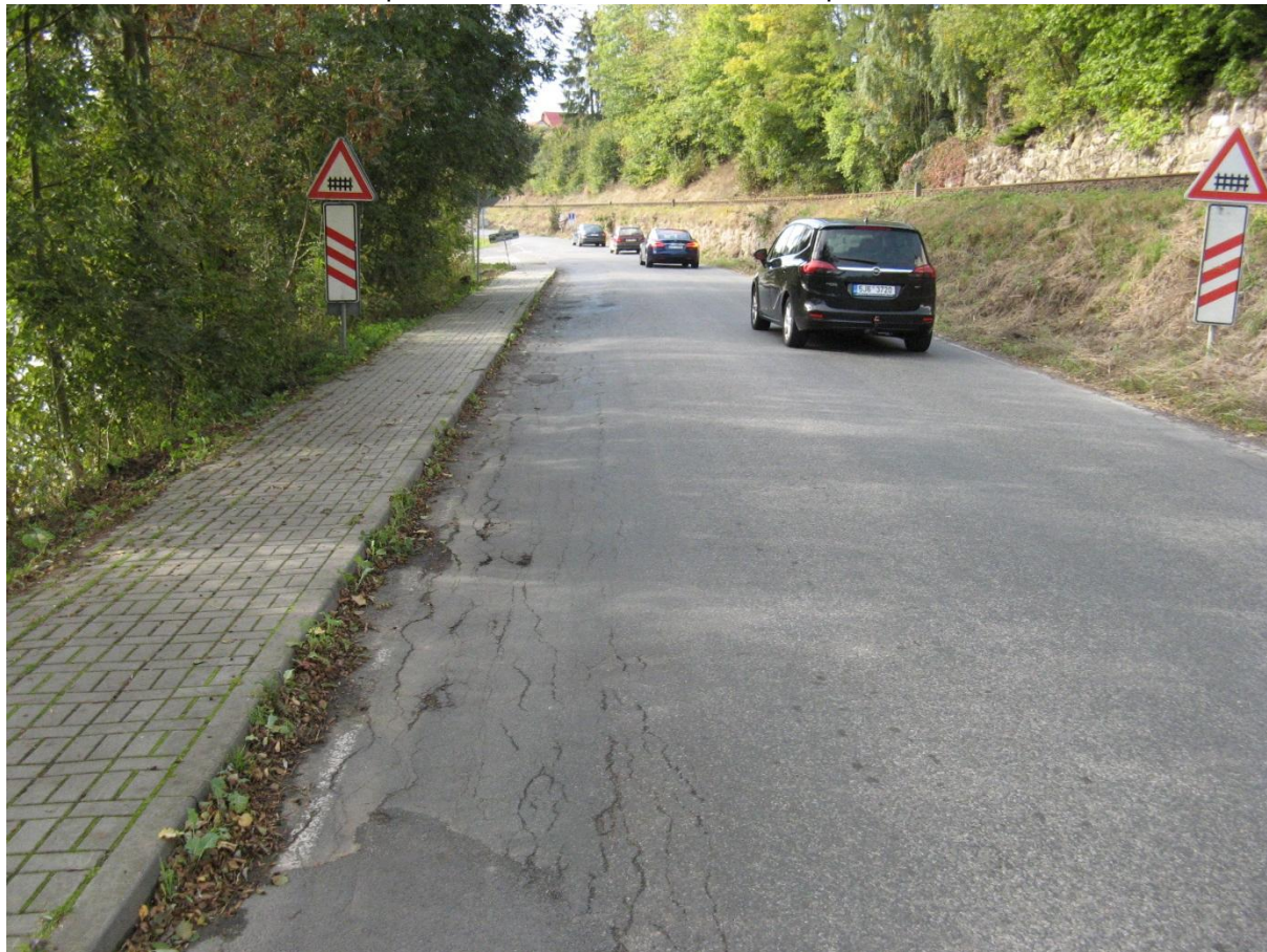
F22, km 8,500- Síťové trhliny podél okraje vozovky.
