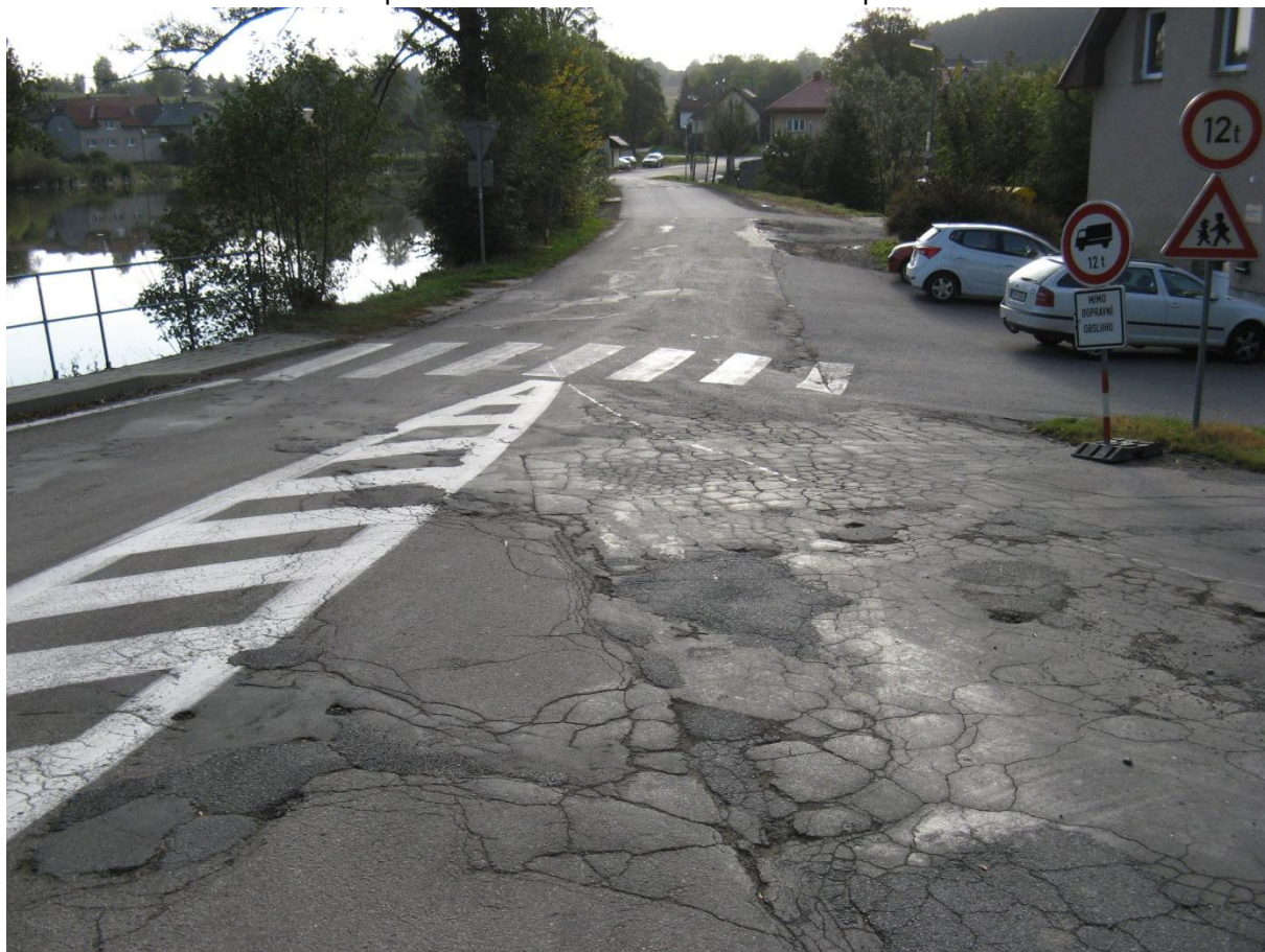
F02, km 0,010+ Síťové trhliny a deformace.
