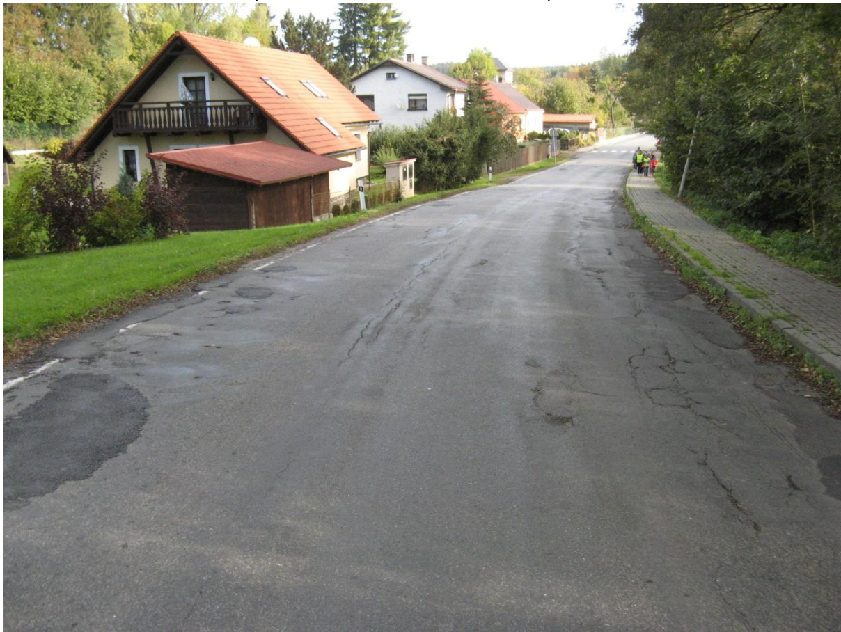
F25, km 8,610+ Síťové trhliny podél okrajů vozovky.
