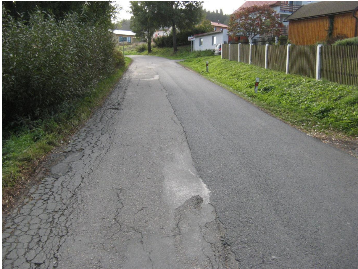
F08, km 0,310+ Síťové trhliny podél okraje vlevo a opravovaný povrch vpravo.
