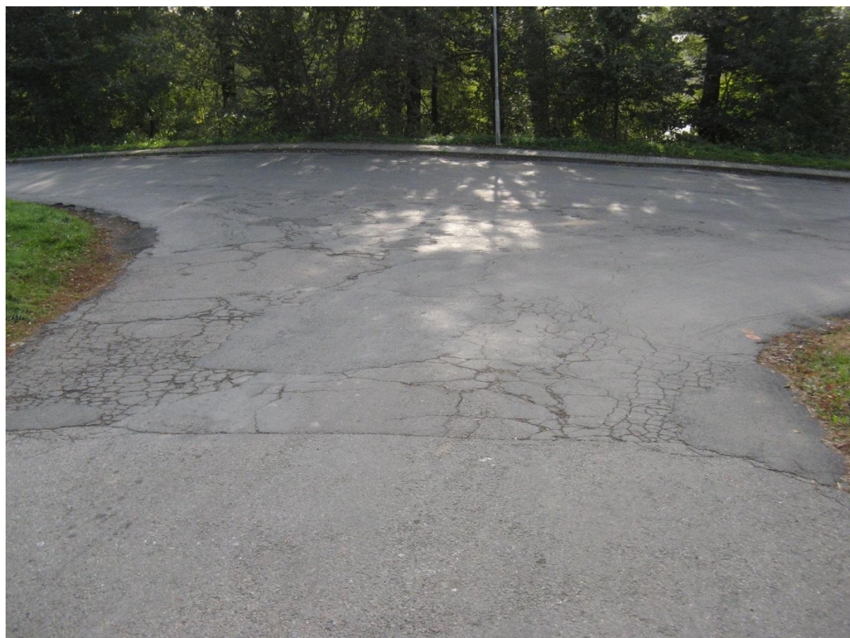
F11, km 5,290+ Síťové trhliny a plošné deformace před křižovatkou.
