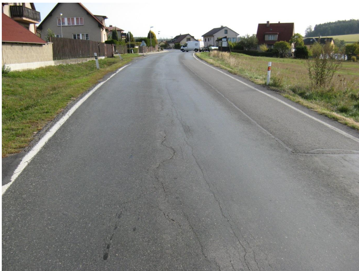
F06, km 7,710+ Velkoplošná vysprávka, podélné rozvětvené trhliny.
